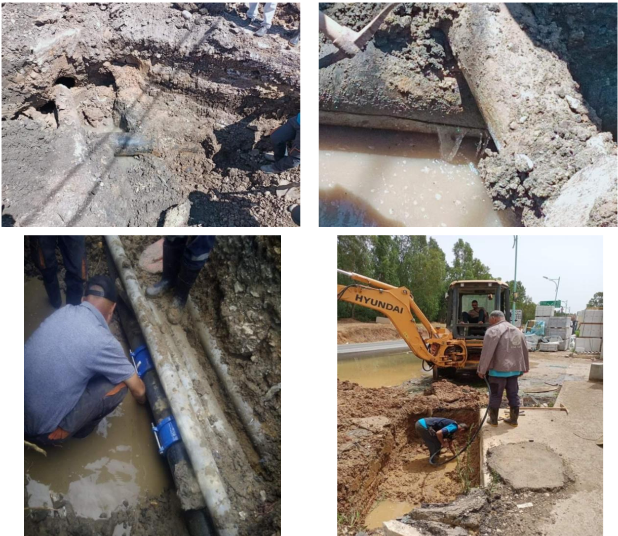
Photo 4.1. Réparation des fuites (El Bouni)
