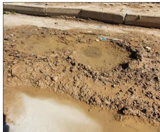
Photo 3.1. Fuites dans les réseaux de distribution
