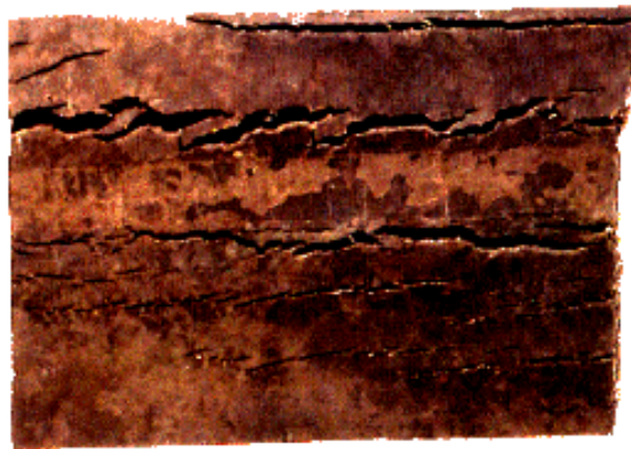
Figure I.8: Fissures de corrosion sous contrainte
